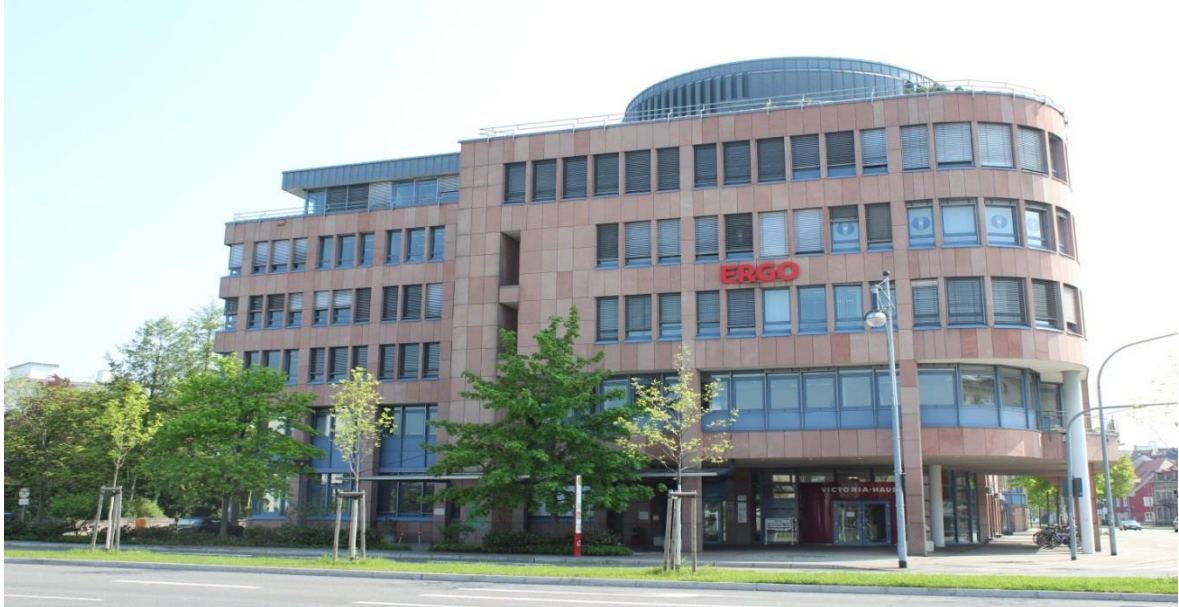
(Victoria-Haus, Freiburg im Breisgau)
